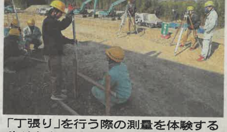
「丁張り」を行う際の測量を体験する生徒たち＝各務原市川島松原町
